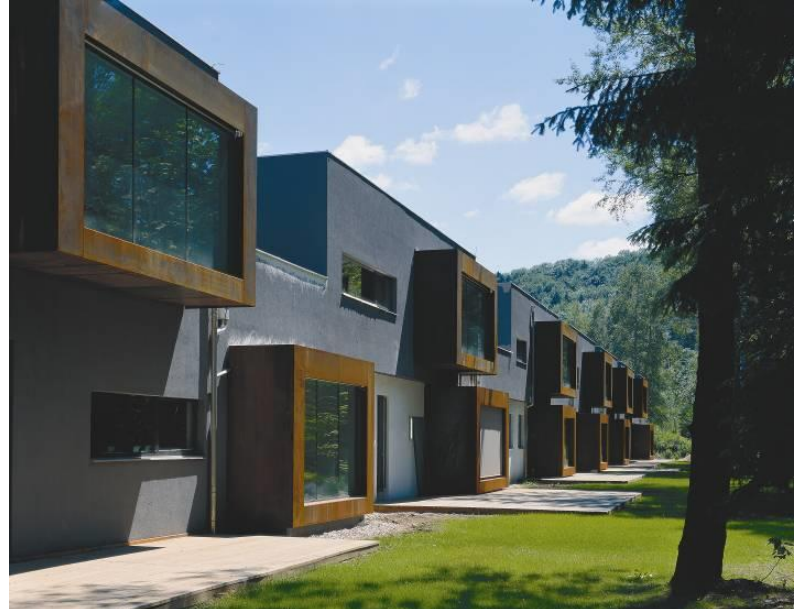
Foto: „Gusswerk Loft Büros Gebäude 7 von Ip architektur“, © Angelo Kaunat
