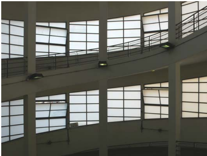
10 Markthalle, 1935–36 Adresse: Triest, Via Carducci 34–36 Architekt: Camillo Jona
