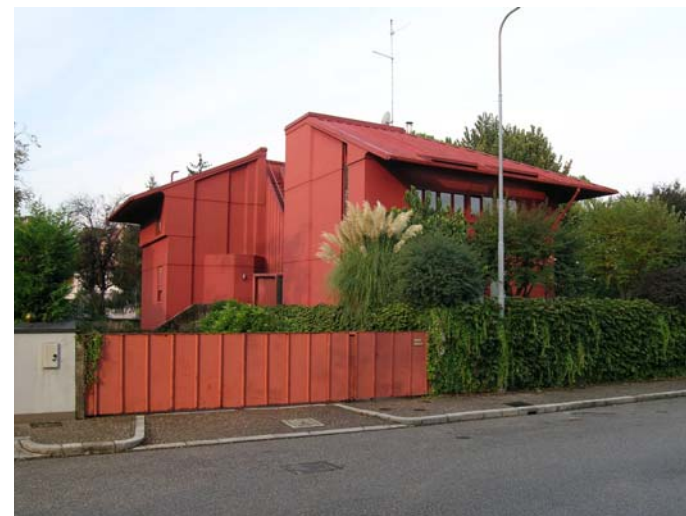
23 Rotes Haus, 1965–66 Adresse: Udine, Via Volta 24 Architekt: Gino Valle
