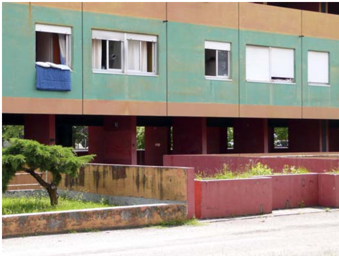
24 Wohnhaus, 1976–79 Adresse: Udine, Via Riccardo Di Giusto Architekt: Gino Valle
