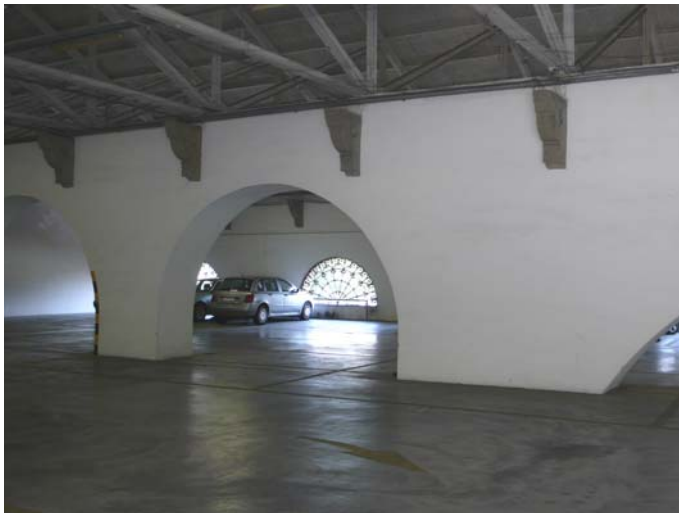
4 Umnutzung der Silos: Parkgarage, Busbahnhof, Markt, 1986–89 Adresse: Triest, Piazza della Libertà, Piazzale della Stazione Architekten: Luciano Semerani, Gigetta Tamaro
