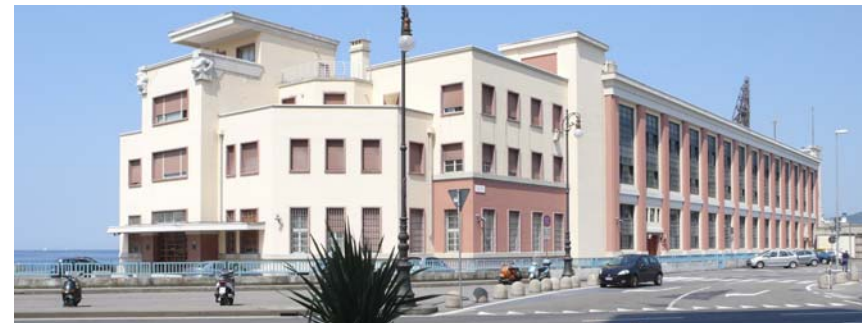
2 Idroscalo (ehem. Station für Wasserflugzeuge), 1931–33 Adresse: Triest, Riva Tre Novembre, Piazza Luigi Amedeo Duca degli Abruzzi Architekt: Riccardo Pollack
