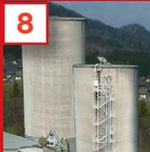
Die 19 Zementsilos haben ein Gesamtfassungsvermögen von 33.000 t. Hier findet auch die Verladung des losen Zements in Silo-LKWs statt (ca. 90 % der Gesamtmenge wird lose verladen).
