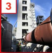
Das gemahlene Gestein, das Rohmehl, wird im Wärmetauscher vorgeheizt, bevor es im Drehrohrofen bei 1.450° C gebrannt (gesintert) wird.
