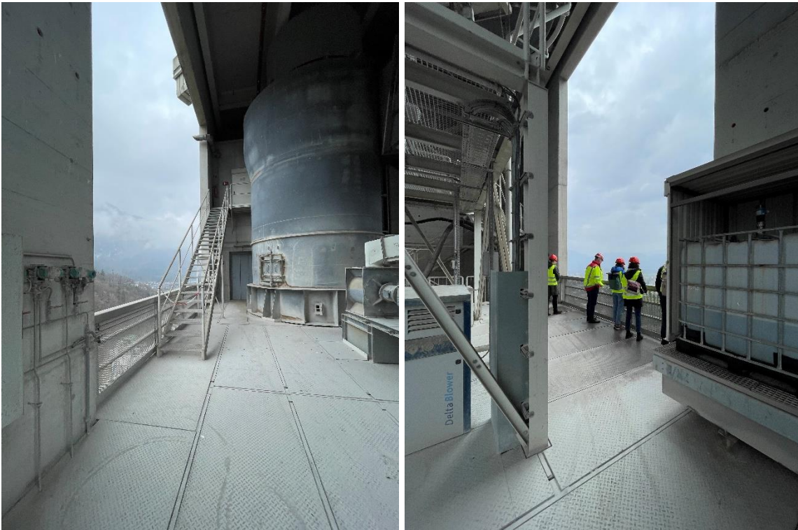
Begehung des Wärmetauschers © Clara Kanz
